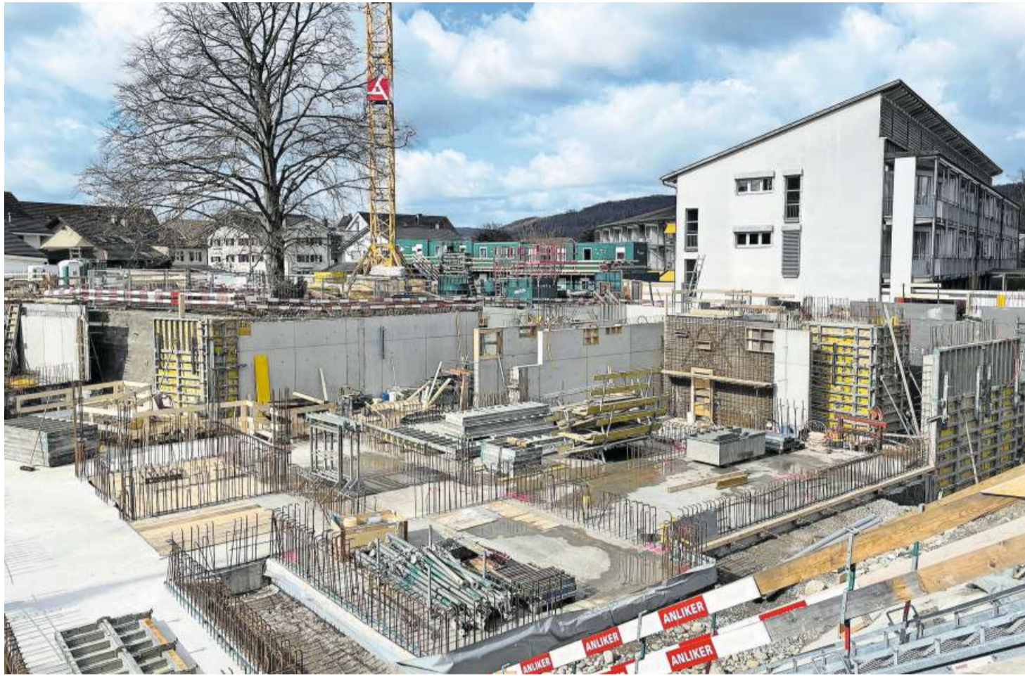
Im September starteten die Bauarbeiten am neuen Alterszentrum Rinau Park, im Sommer 2023 soll es bezogen werden.
